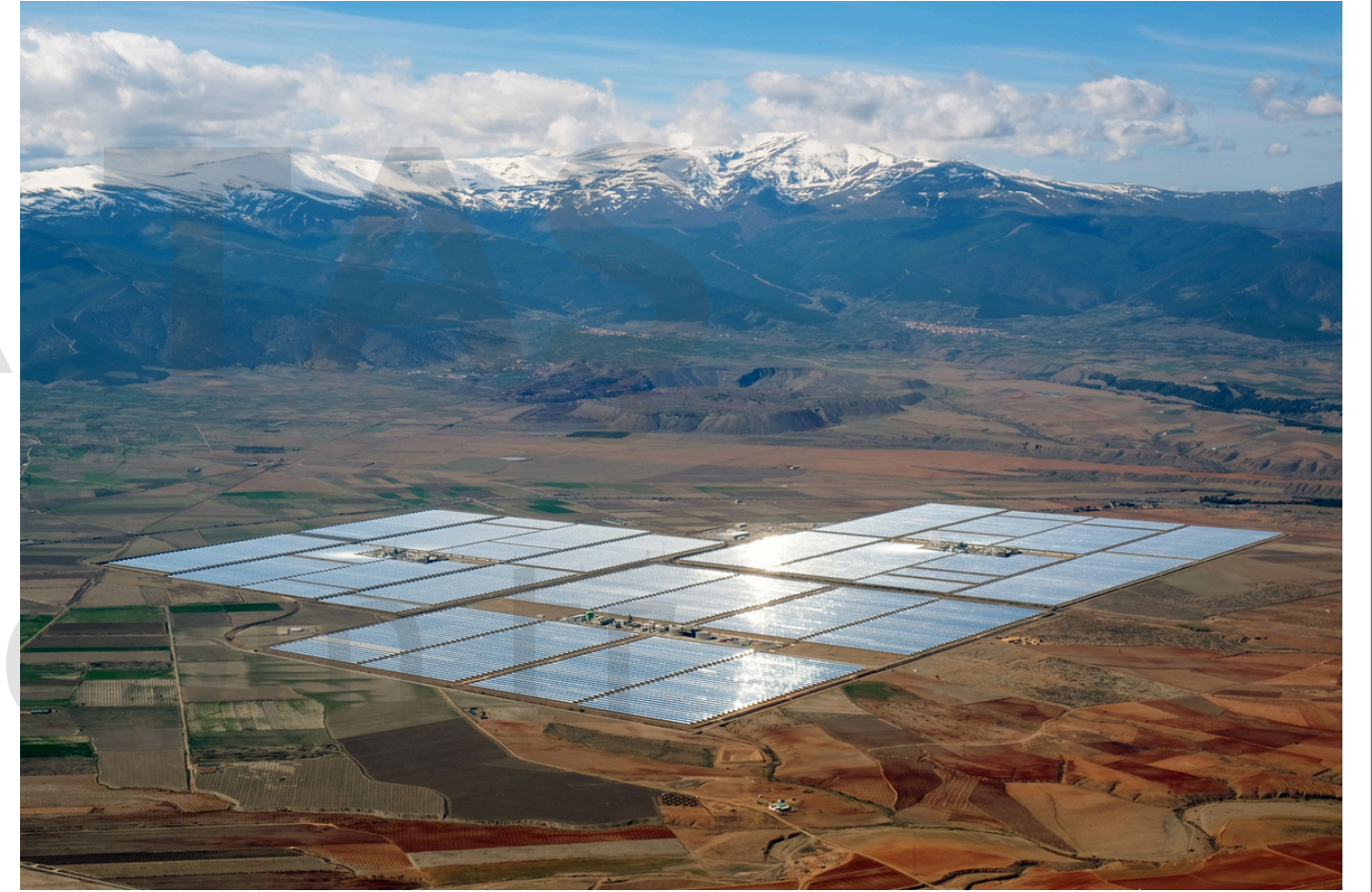
Görsel 9: Andasol Solar Güç İstasyonu'nun Uzak Fotoğrafı (Fotoğraf: Kallerna)
